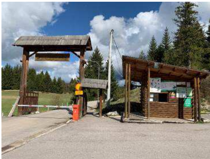
Slika 31: Ulazna kapija i naplatna kućica u ZP Bijambare
