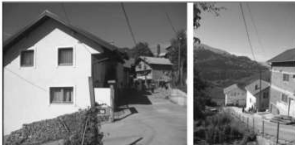
Slika 24: Novozgrađeni objekti u naselju Čibradža
