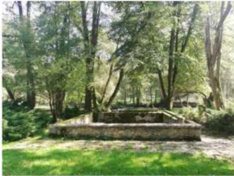
Slika 14: Temelji bivšeg objekta Bosna folklor
