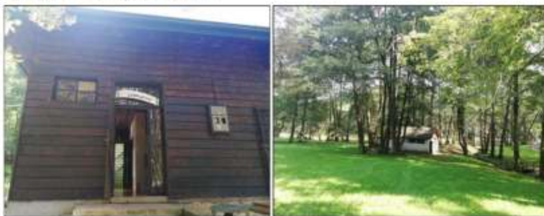
Slika 13: Sjedište Upravljača i javni toalet (lijevo), objekat za opremu i alat (desno)
